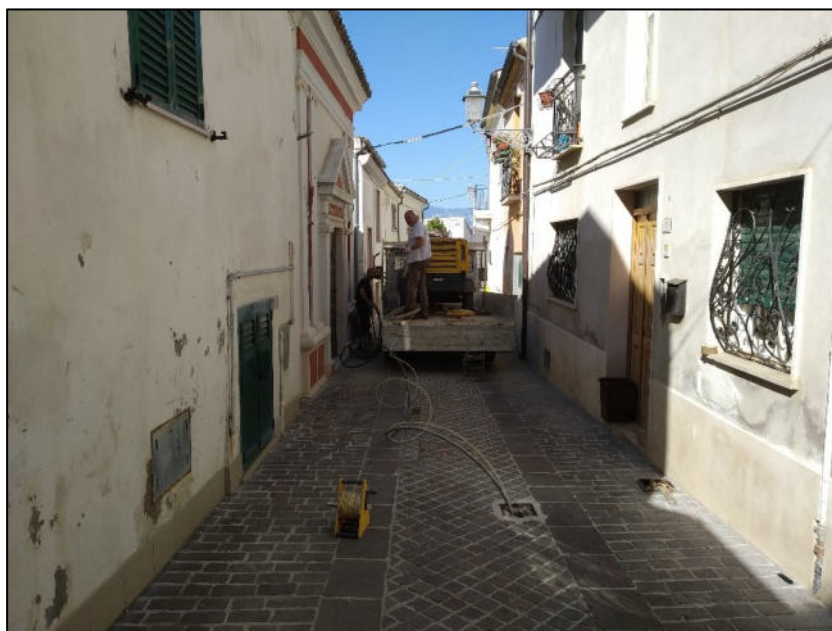
Sondaggio B3: spurgo con aria compressa
