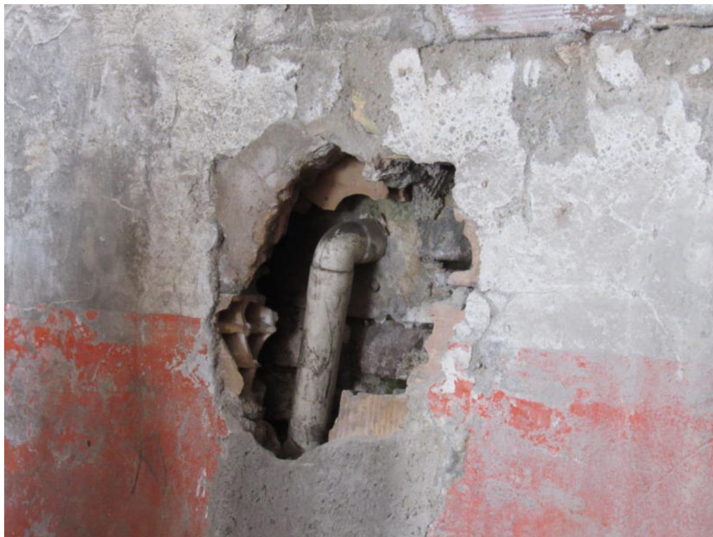
Figura 7 Dettaglio dello scarico di uno dei drenaggi esistenti.
