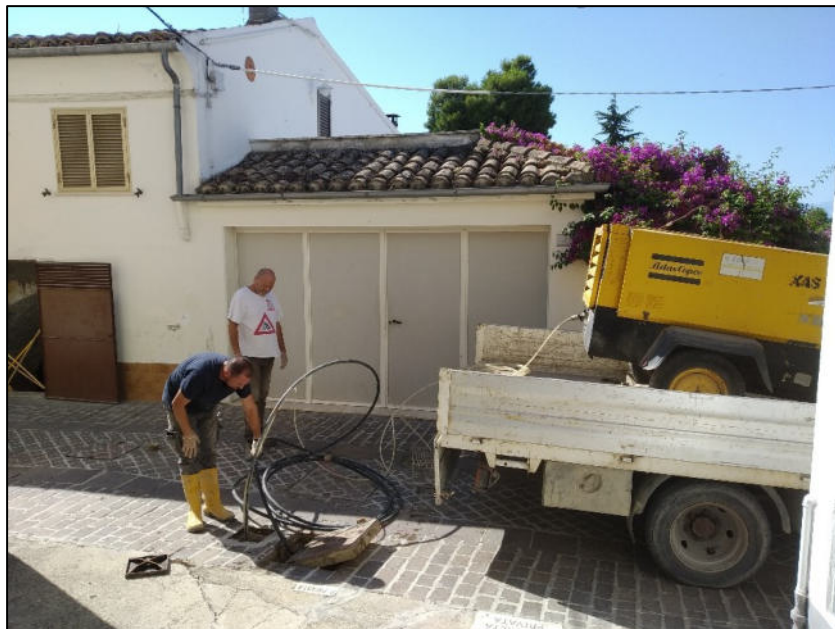
Sondaggio B2: spurgo con aria compressa
