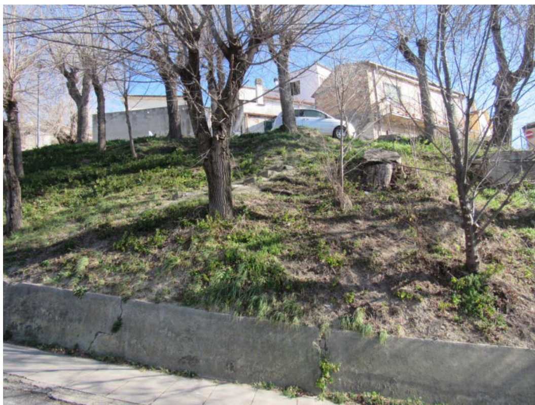
Figura 1 – Vista da valle della scarpa a ridosso di via S. Antonio ed oggetto di stabilizzazione mediante la realizzazione di una paratia di pali a quinconce e soletta a sbalzo anti-erosiva. Il punto di scatto, rappresenta la zona in cui andrà a realizzarsi il tratto inclinato della paratia drenante del diametro di 1000 mm.
