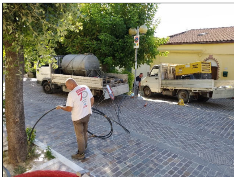
Sondaggio B1: spurgo con aria compressa
