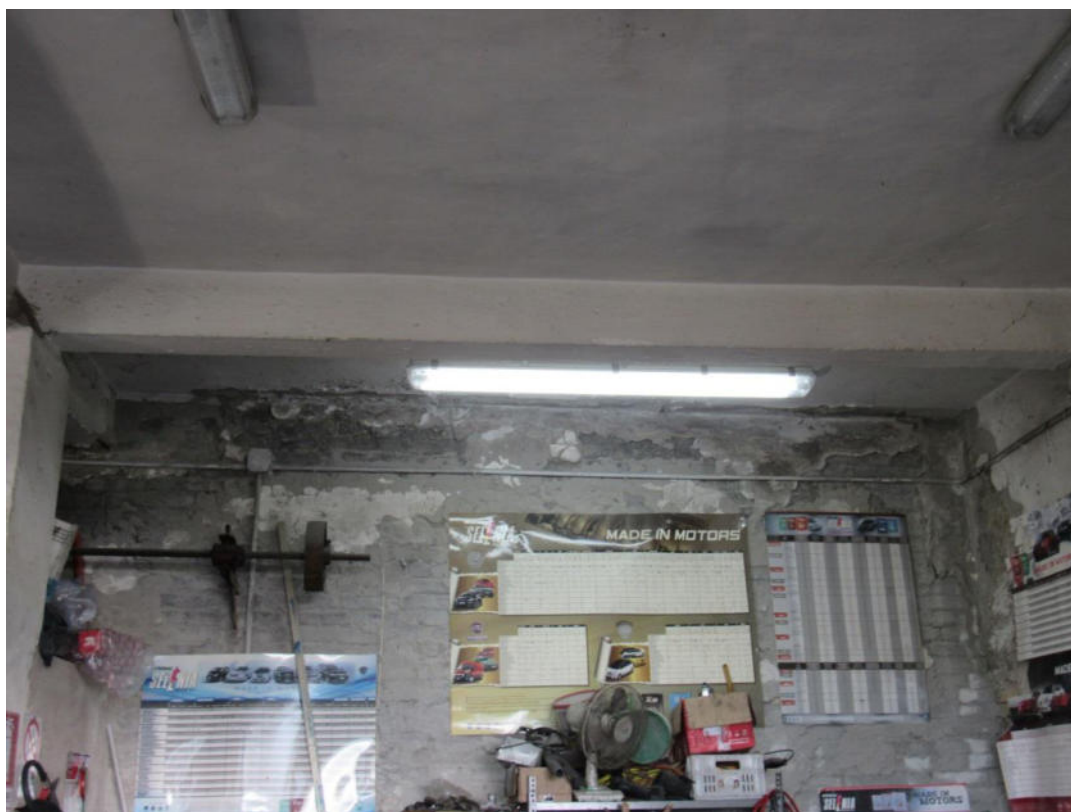
Figura 3 Immagine rappresentativa del fenomeno di trasudazione del muro a ridosso di via S. Antonio – Interno dell'Officina.
