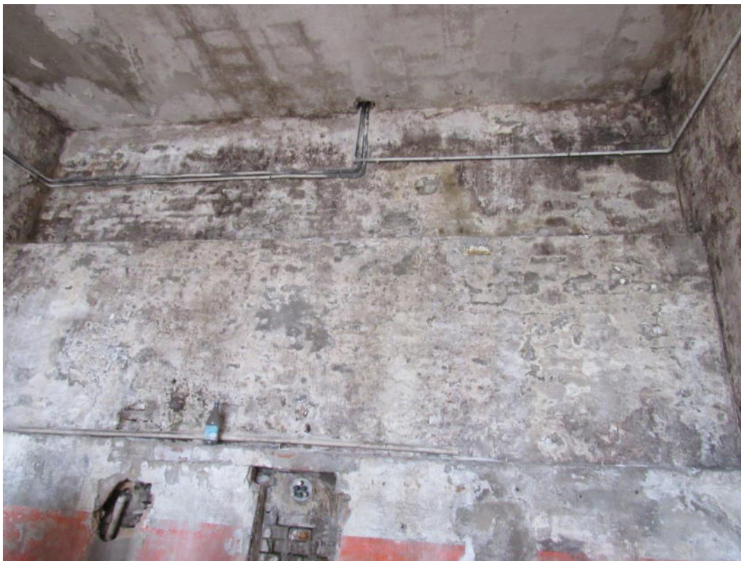
Figura 5 Saggio dell'intercapedine esistente in corrispondenza del muro in mattoni a ridosso di via S. Antonio per ispezionare i drenaggi sub-orizzontali esistenti. È palese il danneggiamento del muro a seguito delle infiltrazioni di acqua
