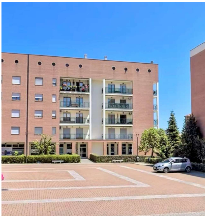
Foto n.1: esterno del fabbricato
