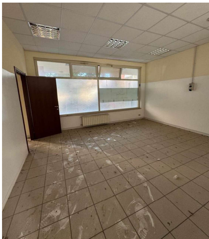
Foto n.4: interno del locale commerciale
