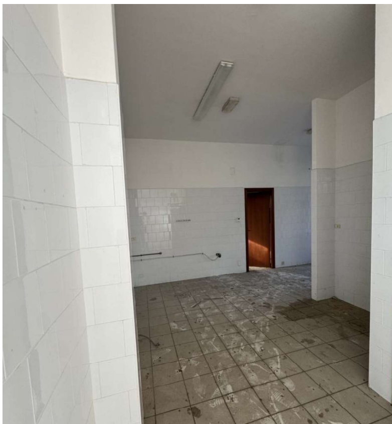
Foto n.7: interno del locale commerciale
