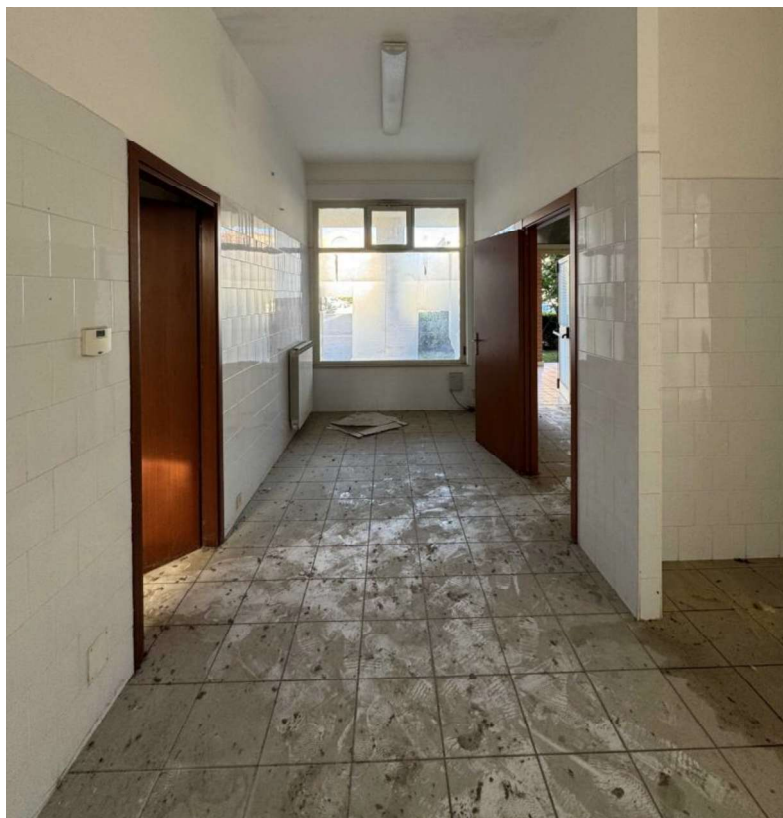
Foto n.5: interno del locale commerciale
