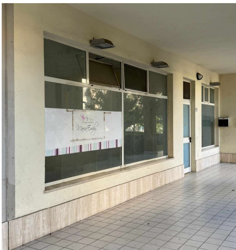
Foto n.2: esterno del locale commerciale
