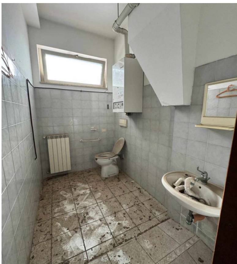
Foto n.8: particolare del wc
